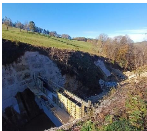
Die zweite Sperre knapp vor der Fertigstellung.
