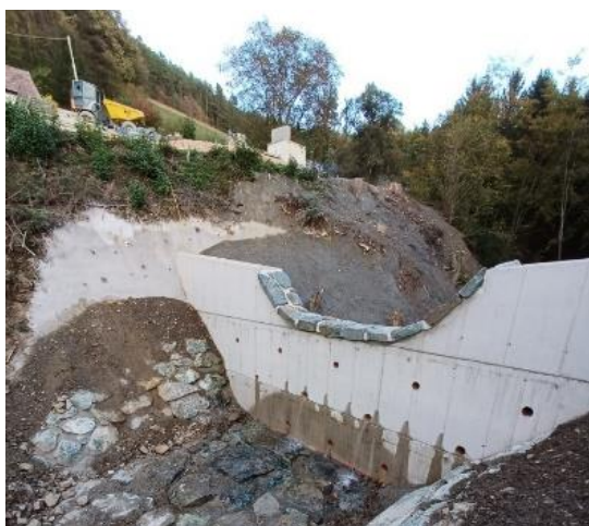
Die erste Sperre ist fertiggestellt.
