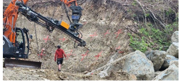
Bohrlafetten werden gesetzt
