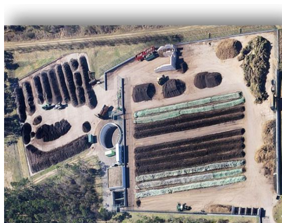
Kompostanlage in Breitenau
