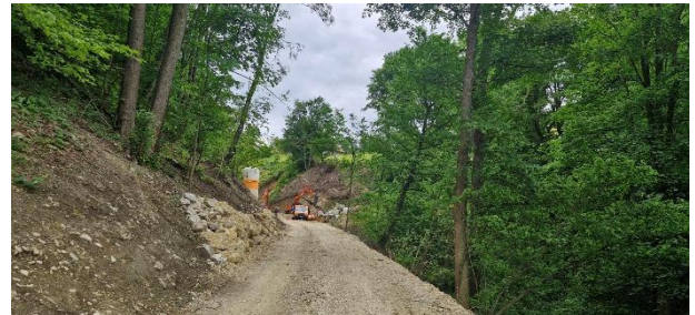
Gesicherte Zufahrt zur Baustelle
